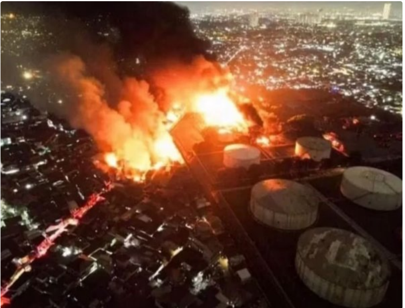
Depo Pertamina Plumpang Meledak
