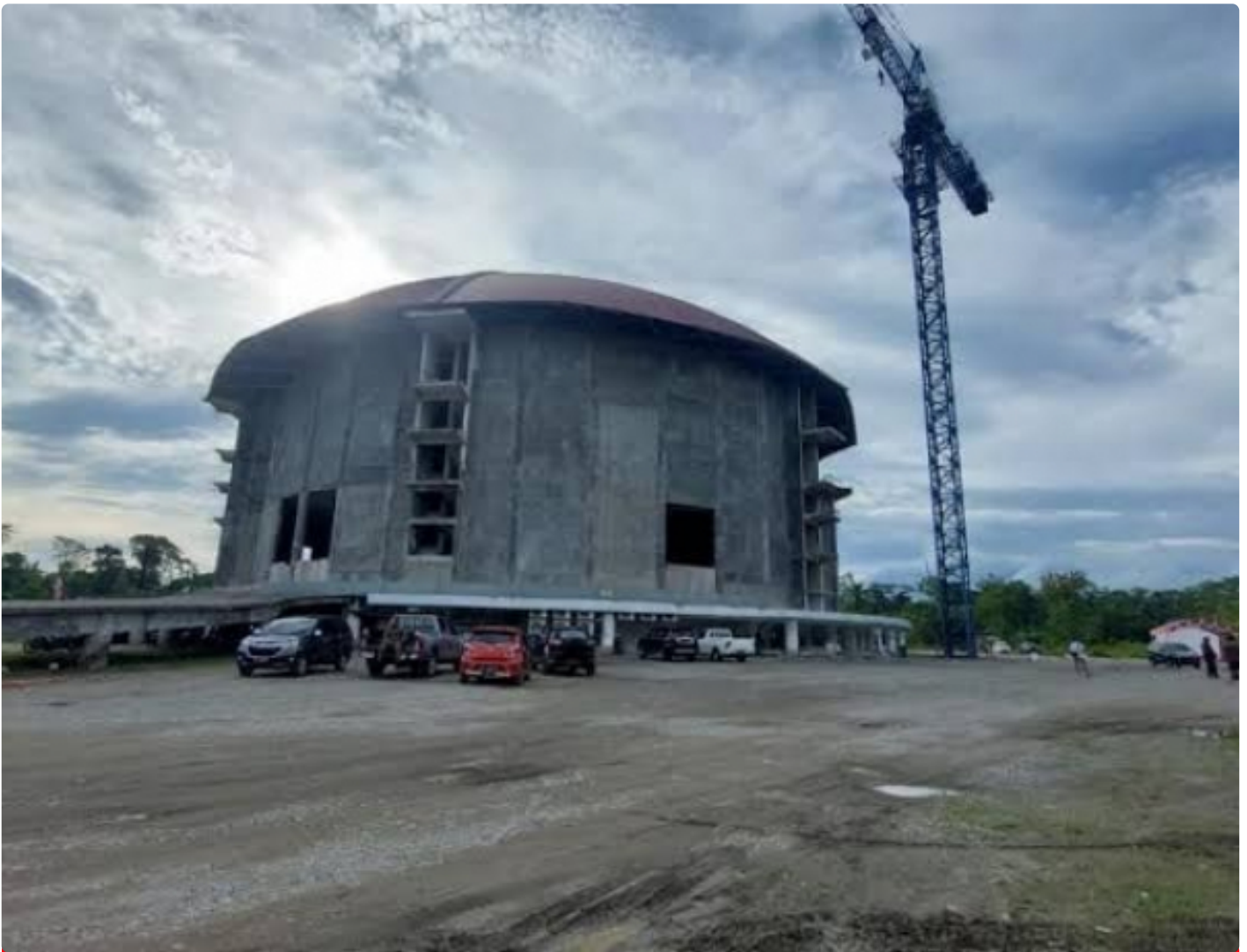
Pembangunan Gereja Kingmi Mile 32
